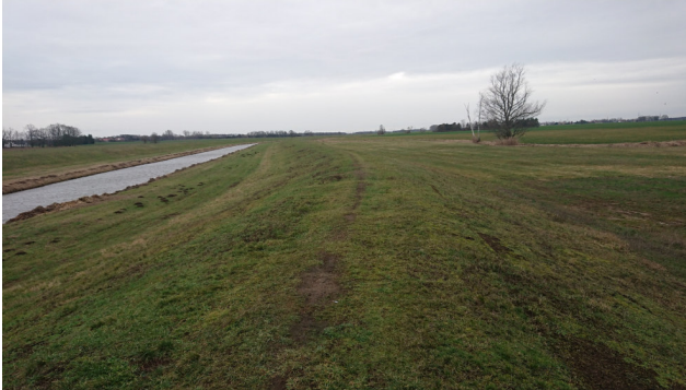
Foto 3: jetziger Zustand des Deiches
