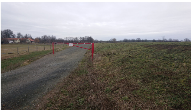
Foto 1: Deichzufahrt bei Reichenhain
